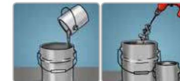
Incorporar la pintura antes de catalizar con un agitador mecánico de bajas revoluciones hasta homogeneizar por completo la resina.
