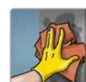
Remover el aceite, grasa, óxido, escoria o escama de laminación, material abrasivo, sales, pintura con pobre adherencia o en mal estado, materiales orgánicos, cualquier otro tipo de contaminantes.
