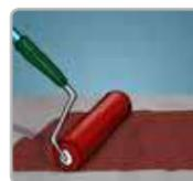
Aplicar el sellador transparente a dos capas con un rodillo liso. Dejar secar de 4 a 6 horas entre cada capa. Para uso peatonal ligero permitir un secado de 24 horas.
