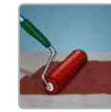
En superficies nuevas o deterioradas aplica una mano del producto diluido al 50% con Solvente N-85 o Xilol como sellado y esperar 24 horas para la aplicación del acabado final. Aplicar dos manos del producto con brocha o rodillo, esperando 24 horas entre cada una.
