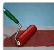
Aplicar una capa con el color deseado con brocha o rodillo y dejar secar por cuatro horas. Dar una segunda mano uniforme. Para uso peatonal ligero permitir un secado de 24 horas.
