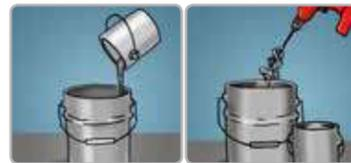
Mezclar los componentes A (resina) y B (endurecedor) independiente hasta obtener una mezcla homogénea.
