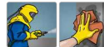
La superficie a pintar deberá limpiarse con chorro de abrasivo con grado de limpieza SSPC SP-6 o más alto, con un perfil de anclaje de 1 a 3 mils de plg. La humedad relativa durante la aplicación y curado no deberá exceder del 85%.
