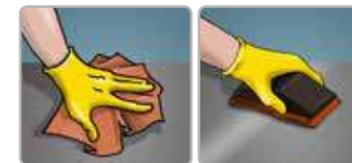
La superficie por pintar deberá estar en buenas condiciones de uso, sin baches, material suelto y completamente seca y libre de aceites, grasas y todo tipo de contaminantes.
