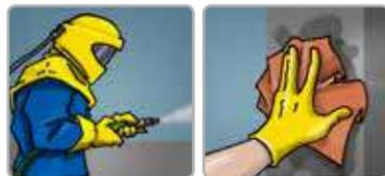
La superficie a pintar deberá limpiarse con chorro de abrasivo con grado de limpieza ISO-Sa21/2 para inmersión o mínimo SSPC SP-6 para condiciones atmosféricas, con un perfil de anclaje de 1.6 a 2.8 mils de plg. La humedad relativa durante la aplicación y curado deber ser mayor a 50%.
