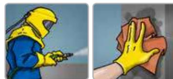
La superficie a pintar deberá limpiarse con chorro de abrasivo con grado de limpieza ISO-Sa21/2 para inmersión o mínimo SSPC SP-6 para condiciones atmosféricas, con un perfil de anclaje de 1.6 a 2.8 mils de plg. La humedad relativa durante la aplicación y curado deberá ser mayor a 50%.
