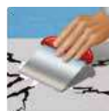
Resane de grietas
